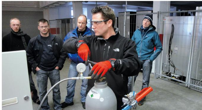
Einfüllen des Kältemittels
