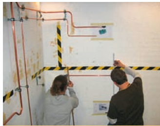
Kälteleitungs montage im Team (KMK 3)
